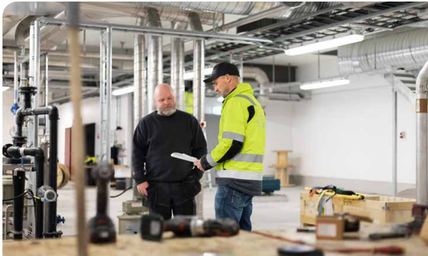
Asgeir Amlien ved Skreia Renseanlegg i samtale med Hveem Elektro.
